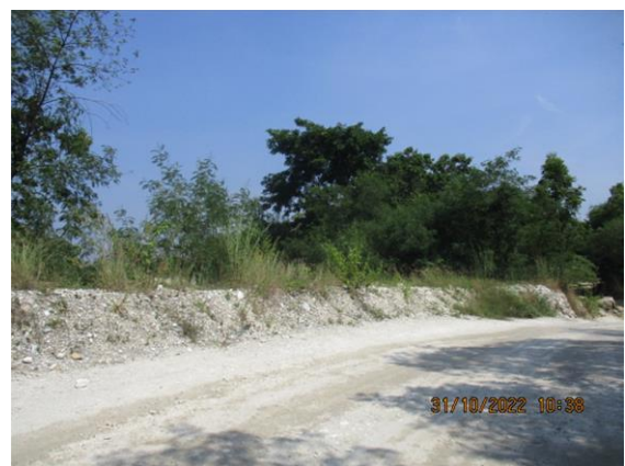
รูปที่ 3-12 เปลือกดินและเศษดินน้ำกลับมากถมปรับพื้นที่ บริเวณบ่อขุดเหมือง
